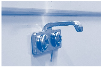
鎖付扣座完成
